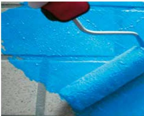
**Caractéristiques techniques:** STARPRIM se compose de polymères spéciaux (styrène butadiène) en dispersion aqueuse, et il est conçu pour obtenir une bonne adhésion sur une grande variété de surfaces, absorbantes et non-absorbantes.
