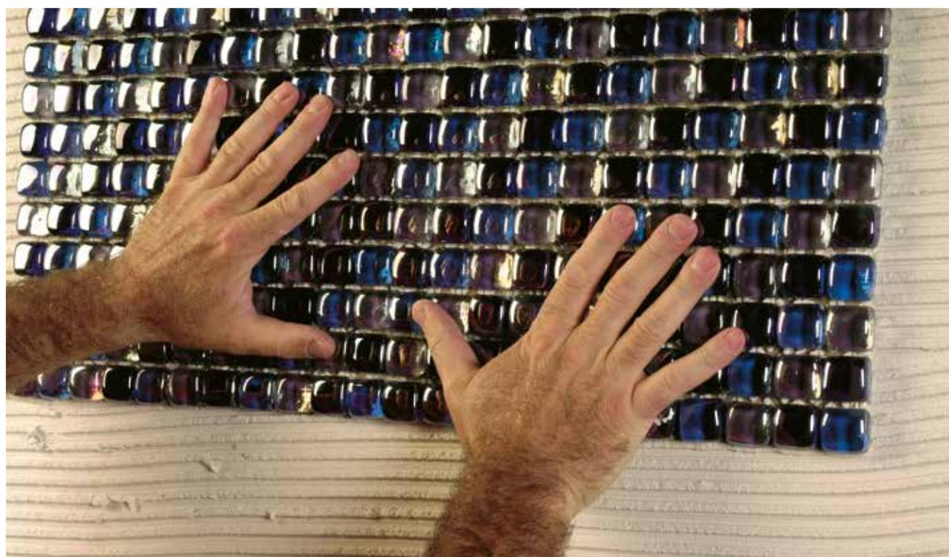
Mortier colle hi-tech très blanc, glissement vertical nul, antigel. Parfait pour la pose de mosaïque (vitreux, grès cérame et marbres) de grès cérame et monocuissant sur sol et mur. Pose de sols renforcés. Hautes résistances finales et long temps ouvert.
