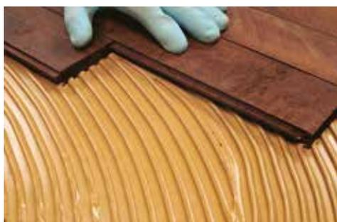
Adhésif spécial pour la pose de parquet de tout type et de n'importe quelle dimension, sur couches en ciment (humidité résiduelle < 2%) et chapes anhydrites (humidité résiduelle < 0,5%), même chauffées. La pose sur des couches avec humidité résiduelle plus élevée par rapport aux valeurs indiquées est possible après avoir appliqué le primaire ASOWOOD-Primer.
