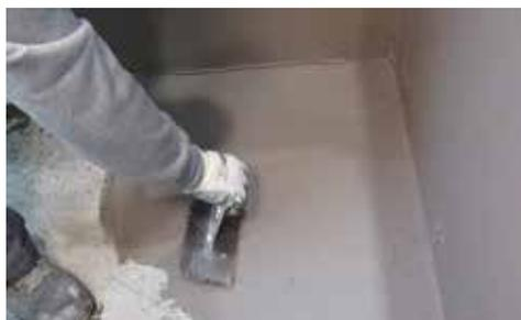
Étanchéité de carrelage en liaison (AIV): pour une étanchéité sûre et économique des ouvrages de génie-civil, sous carrelage lorsqu'une imperméabilité contre l'injection d'eau constante ou à long terme est exigée, par ex. dans les pièces humides, les sanitaires privés et locaux publics.
