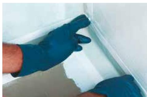
BSWTAPE eco est utilisé pour la réalisation de joints de dilatation et liaisons élastiques et étanches à l'eau sous les carreaux en union avec des membranes d'étanchéité comme ACQUASHIELD-GEL, ACQUASHIELD-1 KF, ACQUASHIELD-2KF, ACQUASHIELD-FAST.
