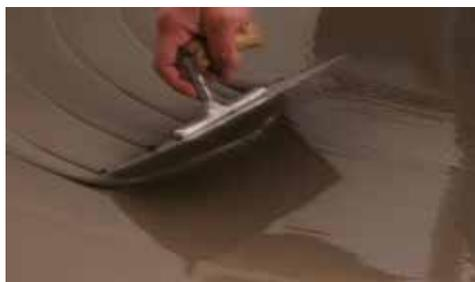
MULTIPLAN-30 est utilisé pour lisser et niveler en épaisseur de 3 à 30 mm. Les supports appropriés se composent de sols en ciment selon les standards industrielles allemands DIN 1045, des chapes chauffantes et non chauffantes en conformité avec DIN 18560, des anciens revêtements céramiques ainsi que des chapes rapides à base de ciment (par exemple SOLIDONE PRONTO). Le produit ne peut pas être utilisé sans application d'un revêtement approprié!
