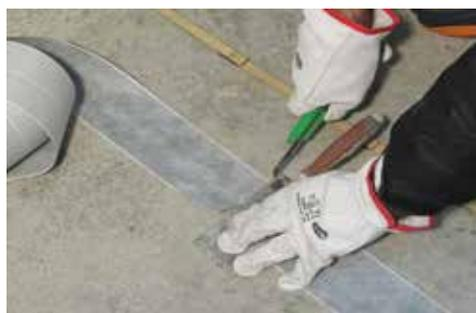
La bande adhésive est encollée sur la sous-couché à l'aide d'une simple pression manuelle avant d'appliquer l'imperméabilisant ou étanchéité, la bande linéaire est posée entre la première et la seconde application.
