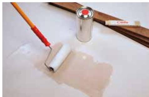
Primaire pour la préparation de couches en ciment (humidité résiduelle < 5-6%) et chapes anhydrites (après ponçage, humidité résiduelle < 1%), à la pose de parquets avec ASOWOOD-2KPU et ASOWOOD-2K. Consolide la chape et avec l'ajout de QUARTZ-Sand (0,2 - 0,7 mm), permet des rasages et des réparations rapides.
