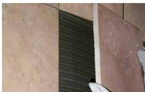
BENFERGRIP C2TE est un mortier colle en poudre très thixotrope, composé de ciment hautement résistant, de quartz à granulométrie choisie, de résines synthétiques et d'additifs spéciaux de dernière génération. Sa formulation a été conçue et développée pour la pose rapide et sûre, même du haut vers le bas, de tous les matériaux céramiques.
