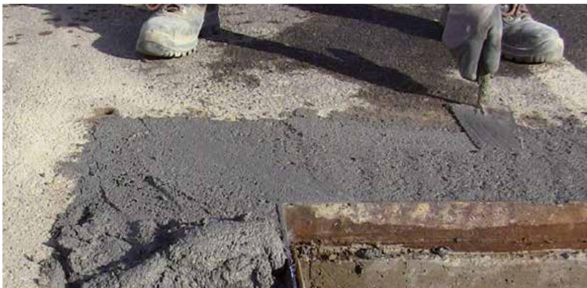
**ТЕХНИЧЕСКИЕ ХАРАКТЕРИСТИКИ:** BENFERCURE-VARIO-40 - это цементный тиксотропный раствор для защиты от коррозии армирующей стали и для защиты бетонной поверхности соответствующей:
