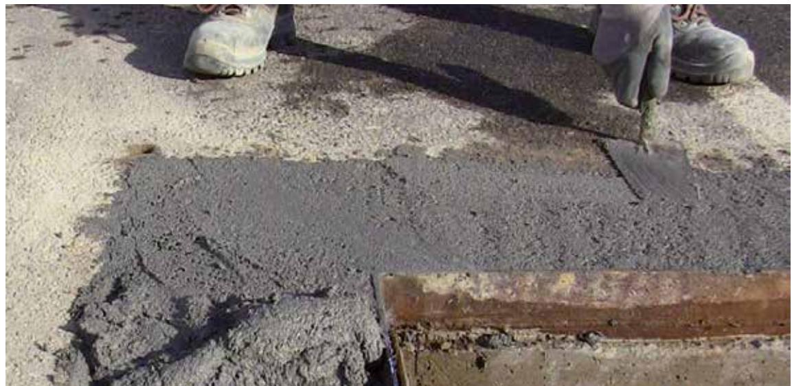
**ТЕХНИЧЕСКИЕ ХАРАКТЕРИСТИКИ:** BENFERCURE-VARIO-10 - это цементный тиксотропный раствор для защиты от коррозии армирующей стали и для защиты бетонной поверхности соответствующей:
