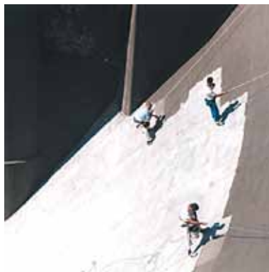
Applicazione a pennello in una diga
