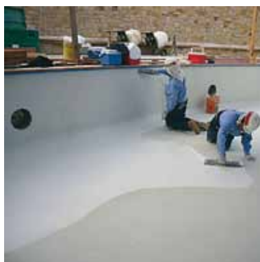
Applicazione a spatola sotto le piastrelle
