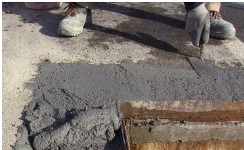
**CARACTERISTIQUES TECHNIQUES:** BENFERCURE-VARIO-40 est un mortier thixotrope à base de ciment pour la protection contre la corrosion des fers d'armature et pour la protection de la surface du béton, conforme à :
