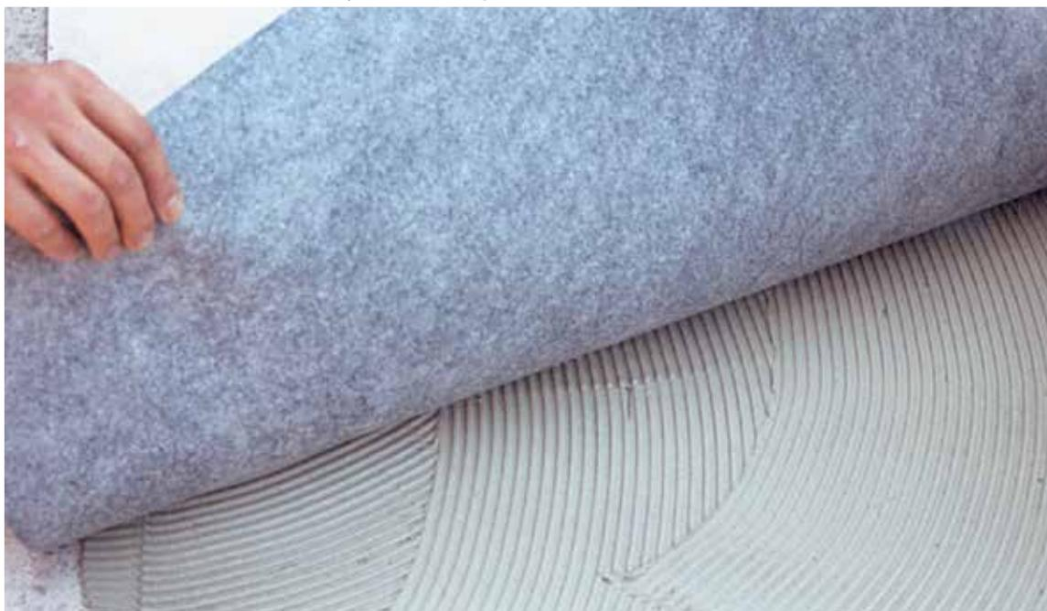
**CARACTERISTIQUES TECHNIQUES:** Membrane d'étanchéité pour balcons, terrasses et en combinaisons avec les imperméabilisants adhésifs et les carreaux dans les locaux humides. Indiquée même comme membrane de découplage sur des sous-couches difficiles et à risque de fissuration.
