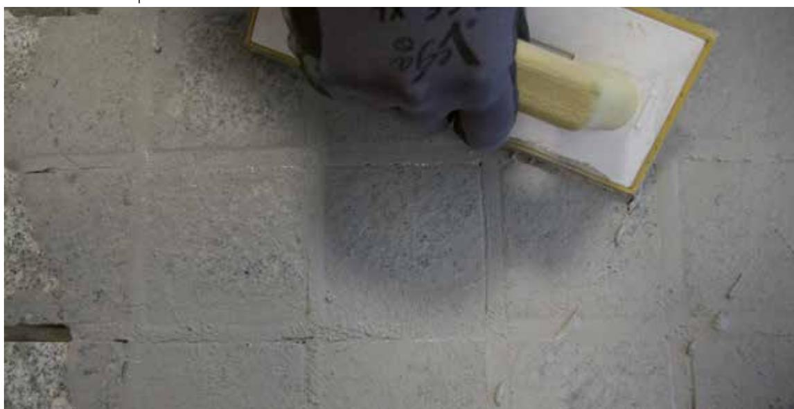
**CARACTÉRISTIQUES TECHNIQUES:** Joint spécial flexible, à prise rapide, pour des joints de 3 à 30 mm de largeur. Les joints DEKOGROUT-HF 1/30 sont composés de ciments spéciaux, inertes à granulométrie sélectionnée et additifs et ils ont été conçus pour durcir rapidement et avec un retrait minimal pour obtenir des résistances mécaniques élevées, une bonne flexibilité et une absorption d'eau minimale, ainsi qu'un bel effet esthétique.
