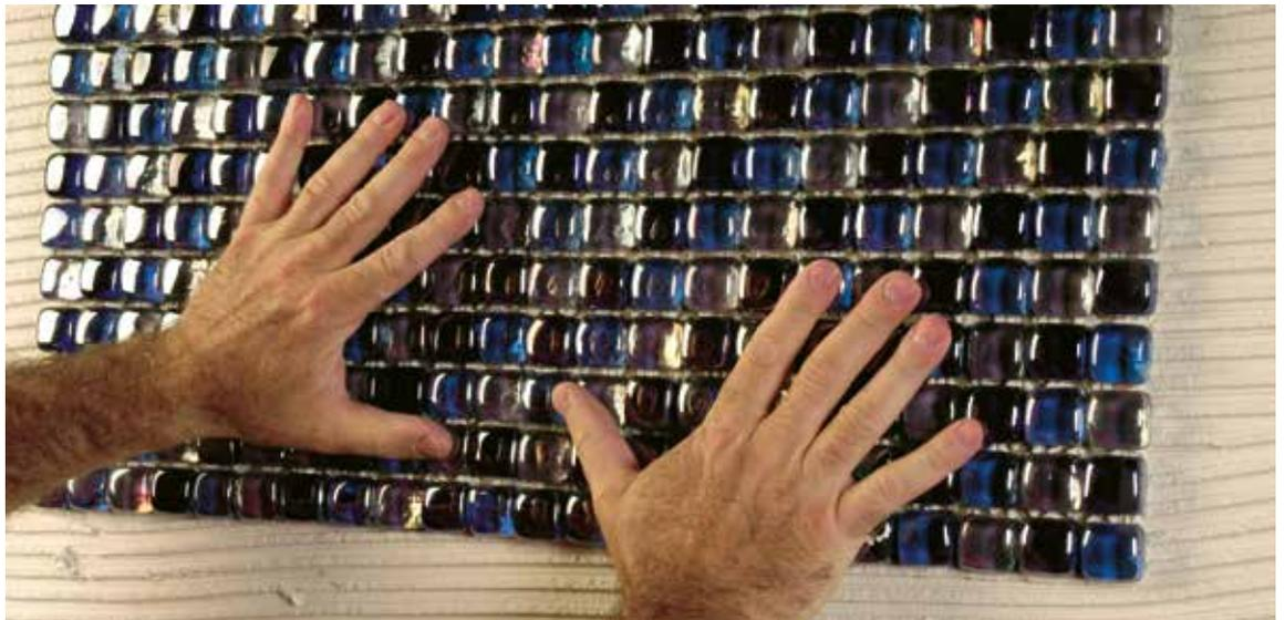
**CARACTERISTIQUES TECHNIQUES:** BENFERGRIP+ est un mortier colle en poudre très thixotrope, composée de ciment hautement résistant, de quartz à granulométrie choisie, de résines synthétiques et d'additifs spéciaux de dernière génération. Sa formulation a été conçue et développée pour la pose rapide et sûre, même du haut vers le bas, de tous les matériaux céramiques.
