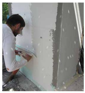
CARACTERÍSTICAS TÉCNICAS: BENFERPLASTER-FI es un adhesivo / nivelante en polvo con refuerzo en fibra para aislamiento térmico exterior compuestio de cemento, inertes de granulometría seleccionada, fibra y resinas y aditivos especiales. Su formula se ha pensado y desarrollado para pegar de manera rápida y segura los paneles de aislamiento exterior.
