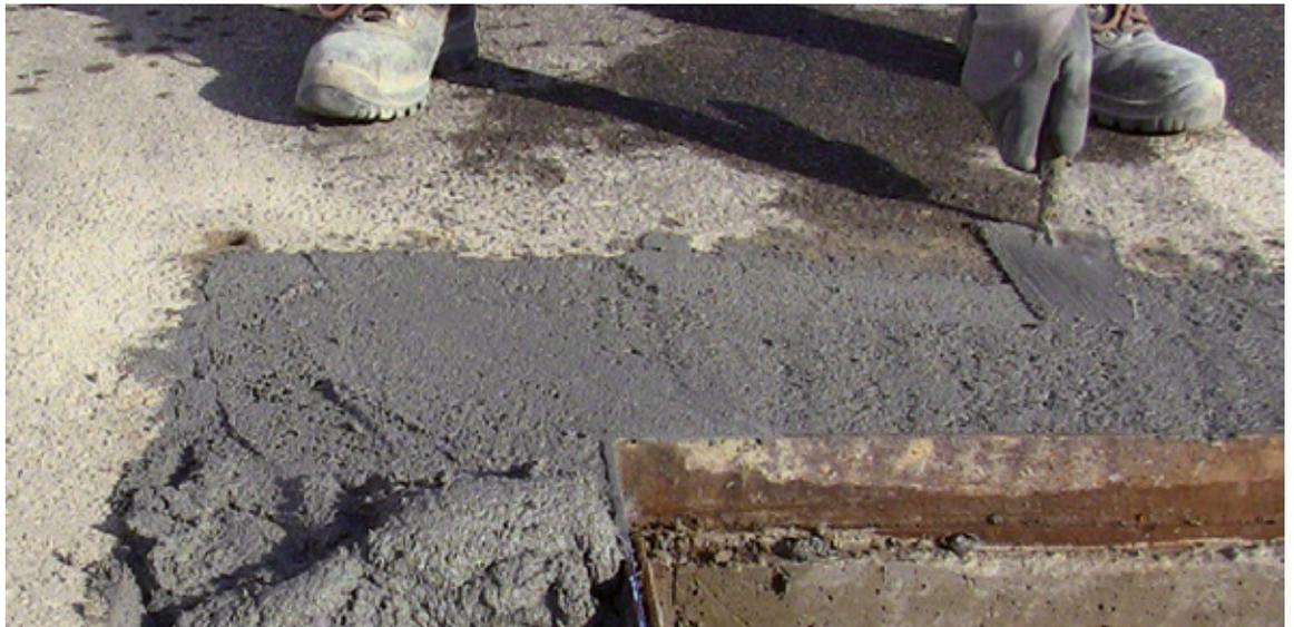
**CARACTERISTICAS TÉCNICAS :** BENFERCURE-VARIO-40 es un mortero base cemento tixotrópico de para la protección de la corrosión de los hierros de armazón, para protección de la superficie del hormigón, conforme a:
