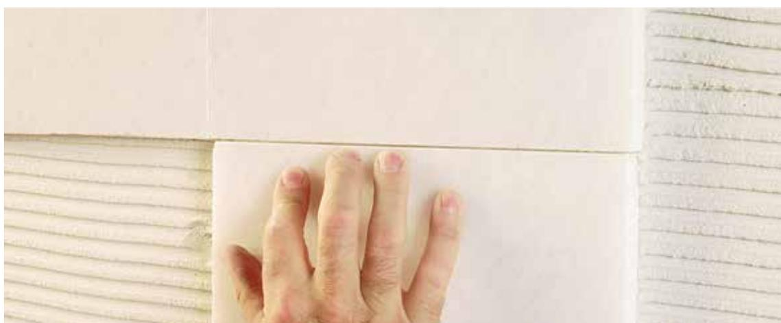
**CARACTERÍSTICAS TÉCNICAS:** BENERFLEX RAPIDO es un adhesivo flexible compuesto por cementos con alta resistencia, áridos de granulometría seleccionada, resinas sintéticas y aditivos especiales. Su composición se ha pensado y desarrollado para una colocación rápida y segura de suelos en mármol, granito, piedra natural, gres porcelánico y cerámica en general, incluso sobre superficies no absorbentes o sujetas a mínimas variaciones de dimensión.
