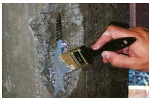
BENFERCURE FERRI es un producto de un solo componente en polvo a base de cemento, áridos seleccionados, polímeros y aditivos especiales inhibidores de la corrosión.
