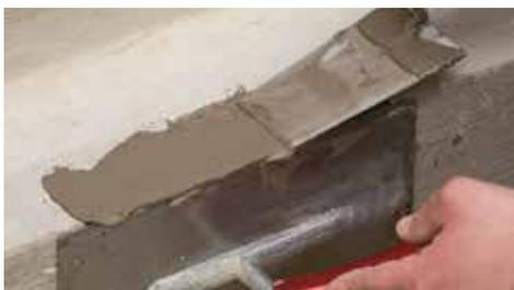
TRIOTECH-30 es un mortero nivelante a base cemento, modificado con polímeros, utilizado para crear superficies planas y para una aplicación posterior de impermeabilizantes o revestimientos.
