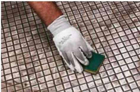
Sellador especial y flexible, de fraguado rápido, para juntas de 2 a 12 mm de ancho.
