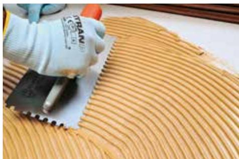
Adhesivo epoxipoliuretánico bicomponente sin agua, específico para encolado de pavimentos de madera de cualquier tipo sobre morteros de nivelación a base de cemento o sobre pavimentos antiguos (mármol, baldosas, pavimentos en piedra en exteriores, soportes de madera).
