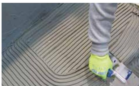
Benfer ECOFlex SP es un adhesivo en polvo tixotrópico compuesto por cemento, áridos de granulometría seleccionada, resinas sintéticas y aditivos especiales. Su composición se ha pensado y desarrollado para colocar de manera rápida y segura casi la totalidad de materiales cerámicos, incluso sobre soportes no absorbentes o sujetos a ligeros cambios dimensionales. Además, la elevada resistencia al deslizamiento vertical permite la colocación de los revestimientos empezando desde arriba.
