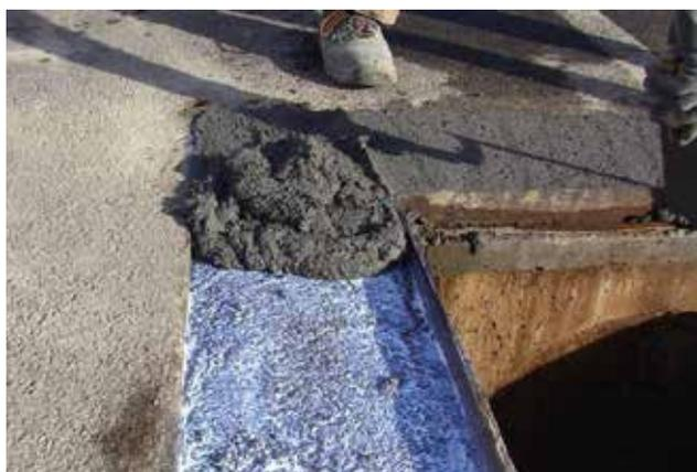
CEMLATEX 600 es una dispersión polimérica para aditar morteros a base de cemento para mejorar su resistencia mecánica, capacidad de adhesión, elasticidad, tiempo de uso e impermeabilidad. Debe utilizarse en sustitución de una parte del agua de mezcla en cantidad variable en función de los usos y de los resultados que se desean obtener.
