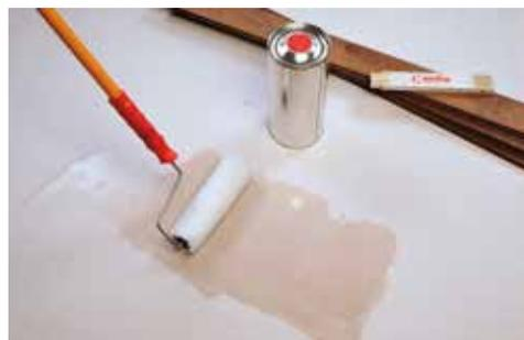
Primer para la preparación de morteros de nivelación a base de cemento (humedad residual < 5-6%) y en anhidrita (lijado anteriormente, humedad residual < 1%), para colocación de pavimentos en madera con ASOWOOD-2KPU y ASOWOOD-2K.
