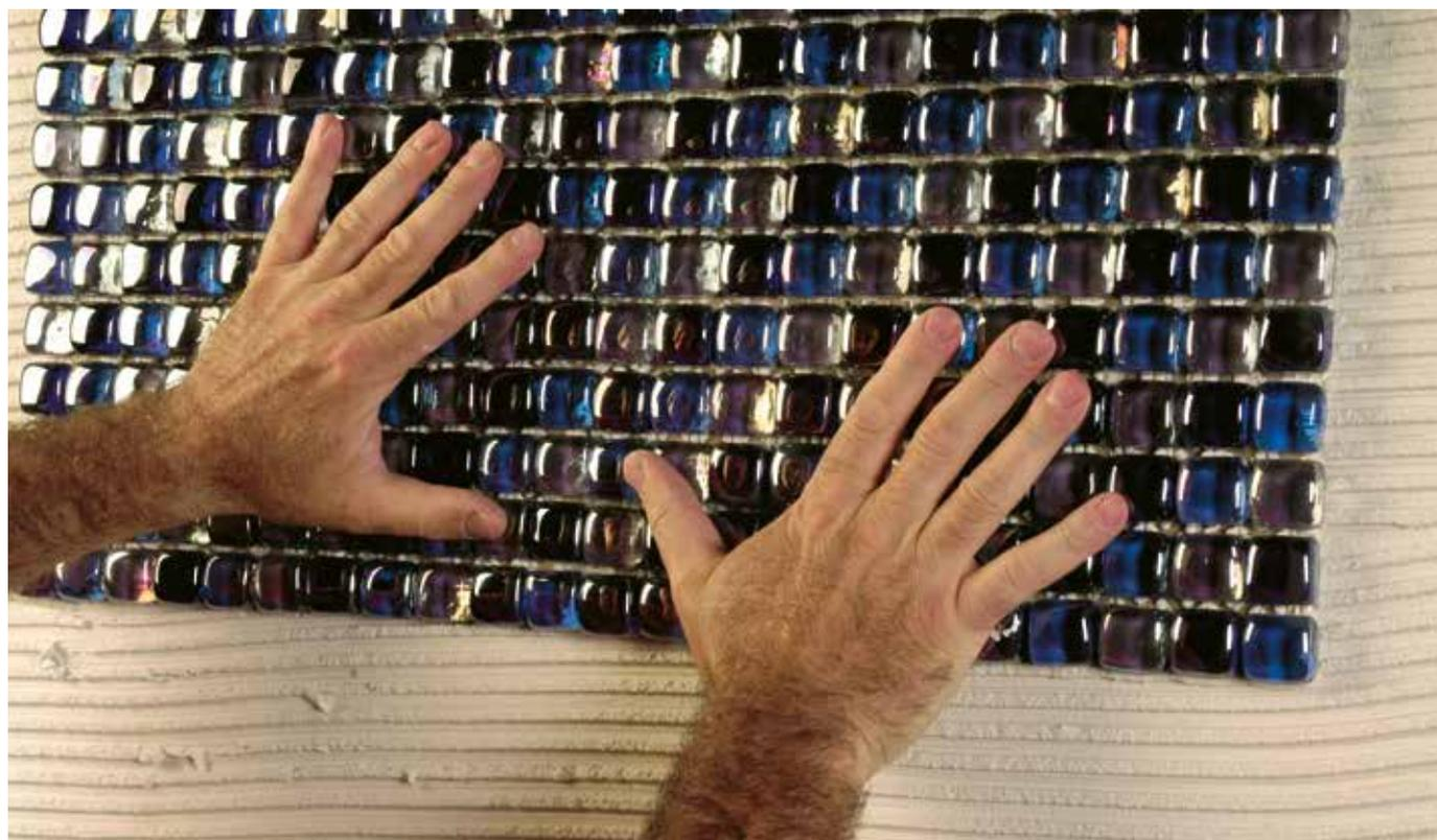
Adhesivo de alta tecnología hiperblanco, deslizamiento vertical nulo, resistente a las heladas. Perfecto para la colocación de mosaico (vítreo, de mármol, de porcelánico), de gres porcelánico, baldosas de monococción a pared y pavimento.
