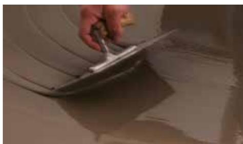
MULTIPLAN-30 se utilizada para alisar y/o nivelar, en grosores de 1 a 30 mm, soportes adecuados son superficies de cemento conforme a DIN 1045, pavimentos cementosos con o sin calefacción conforme a DIN 18560, embaldosados viejos pero fijos y pavimentos cementosos de fraguado rápido (p. ej. SOLIDONE PRONTO). No es adecuado como superficie transitable sin un recubrimiento adicional previsto como capa de tránsito.
