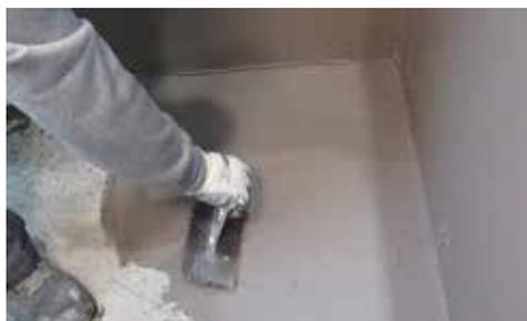
Sistema de impermeabilización en adherencias con baldosas: para una impermeabilización segura, durable y eficaz bajo las baldosa que están en contacto constante con agua, p.ej. en baños y cocinas en áreas residenciales, en sanitarios privados y públicos así como balcones y terrazas. Las juntas entre pavimento y pared deben reforzarse con BSWTAPE.
