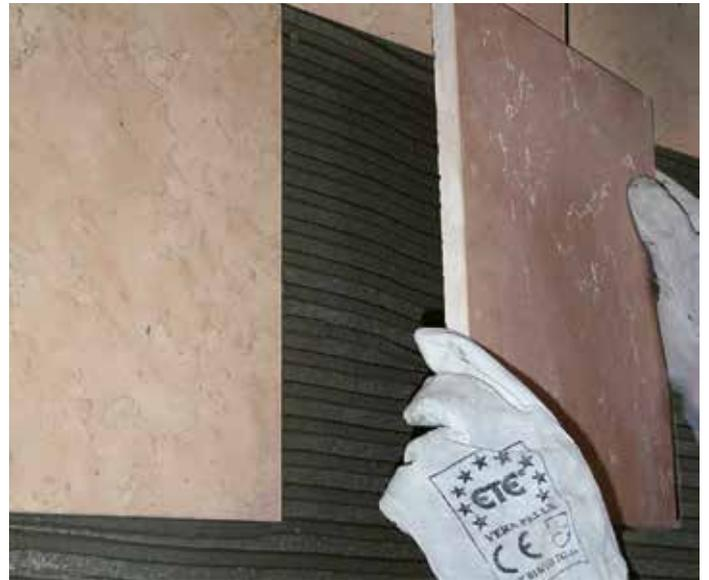
**ANWENDUNGSBEREICHE:** Verlegung von Feinsteinzeug, nicht saugfähigen Einbrandfliesen, Glas- und Keramikmosaik und feuchtigkeitsbeständigen Natursteine bei:
