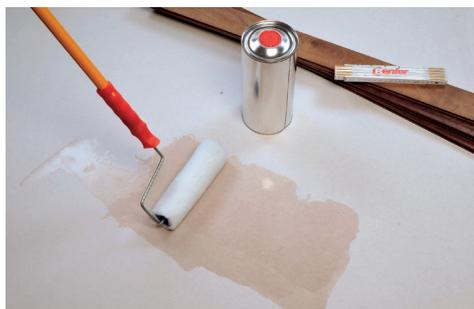
Grundierer für die Vorbereitung von Zementestrichen (Restfeuchtigkeit < 5 - 6%) und Anhydritestrichen (nach Abschleifen, Restfeuchtigkeit < 1%) für die Verlegung von Parkett mit ASOWOOD-2KPU und ASOWOOD-2K. Verfestigt den Estrich und mit Hinzufügung von QUARZ-Sand (0,2 - 0,7 mm) erlaubt er schnelle Feinspachtelung und Reparaturen.
