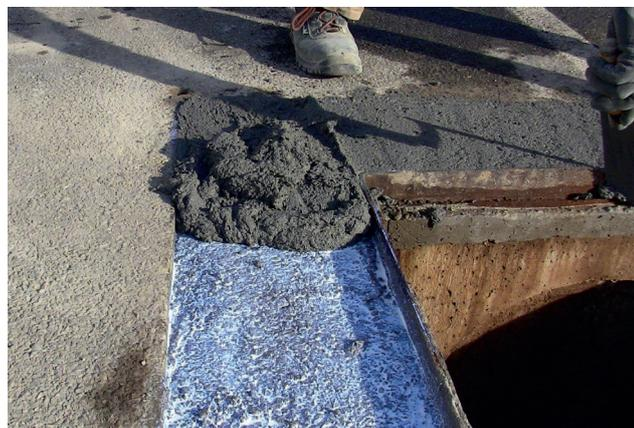
CEMLATEX 600 ist eine Polymerdisposition, welche Zementmörtel zugegeben wird. Erhöht den mechanischen Widerstand, die Elastizität, die Haftung an den Untergründen und die Wasserundurchlässigkeit. CEMLATEX 600 wird als Ersatz eines Teils der Wasserzugabe verwendet, in unterschiedlichen Mengen, je nach gewünschten Anwendungen und Ergebnissen.
